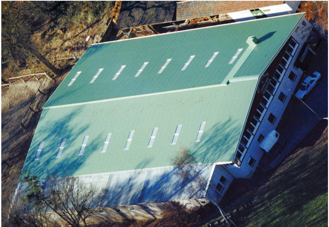
Das neue Hallendach mal aus der Vogelperspektive!
